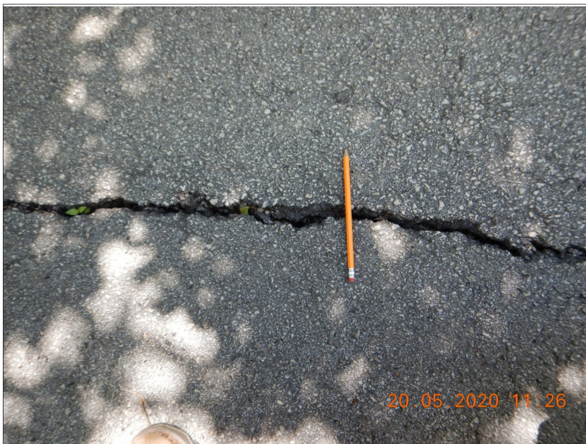
Spękania na drodze przebiegającej przez osuwisko (maj 2020)
